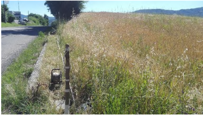
Figura 22 – Piazzamento prospezione MASW
